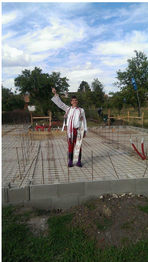
Hodová kontrola stavby
